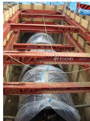
【耐震性貯水槽の設置工事の様子】
