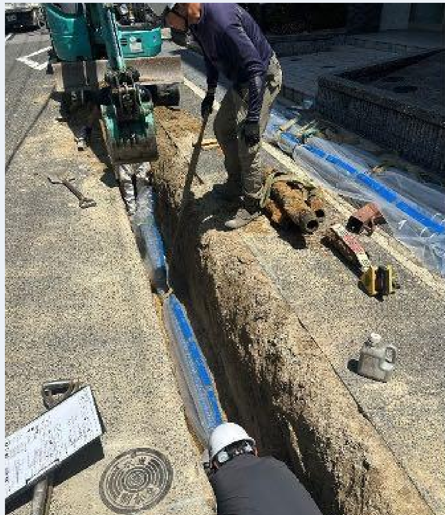
水道管の更新
