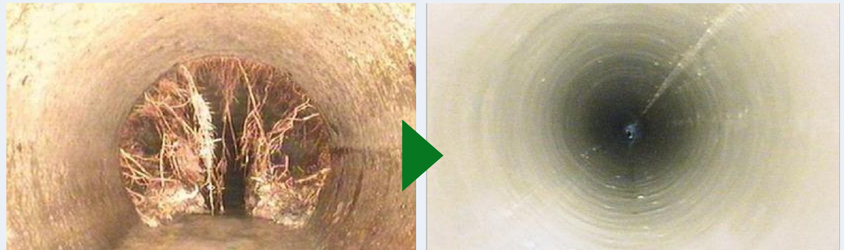
下水道管の更新
