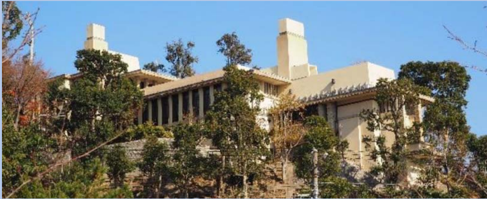
[国指定]旧山邑家住宅（ヨドコウ迎賓館） （所有者：株式会社淀川製鋼所）
