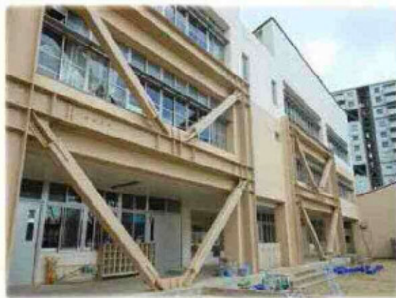
耐震改修した潮見小学校
