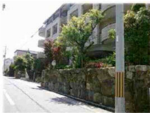
石積擁壁や緑化に配慮した住宅
