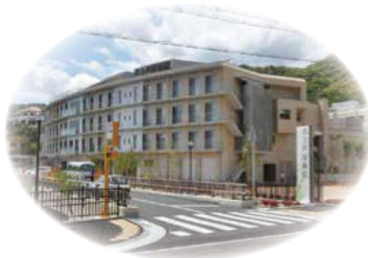
芦屋病院外観
