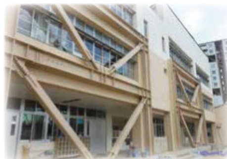
耐震改修した潮見小学校
