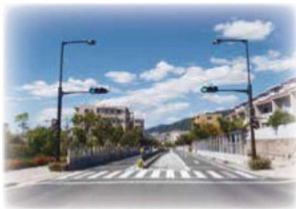
無電柱化している山手幹線
