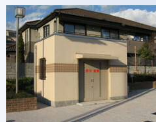
防災倉庫（三条南町）
