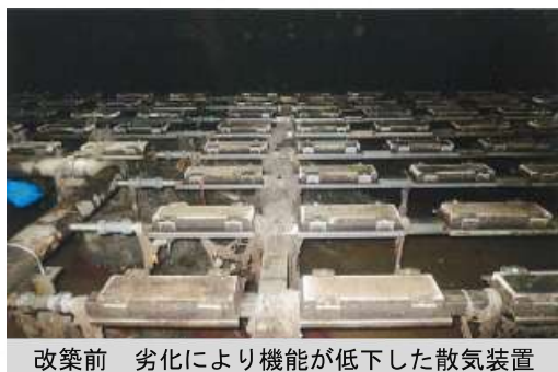
写真8 機械設備の改築状況
