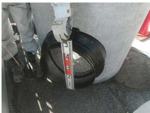
写真 9 マンホールと管路の接続部の耐震化
