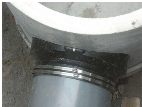
写真 9 マンホールと管路の接続部の耐震化
