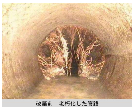
写真 7 管路の改築状況
