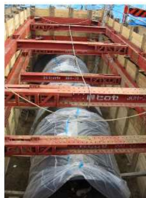
【耐震性貯水槽の設置工事の様子】
