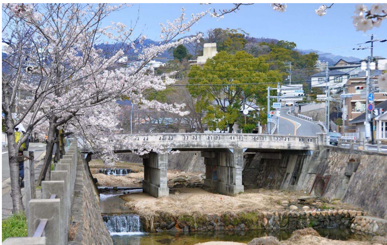
開森橋（施工前）
