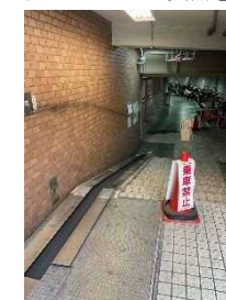
搬送コンベア機器③
