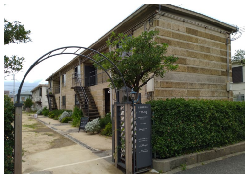
写真 - 旧宮塚町住宅のリノベーション
