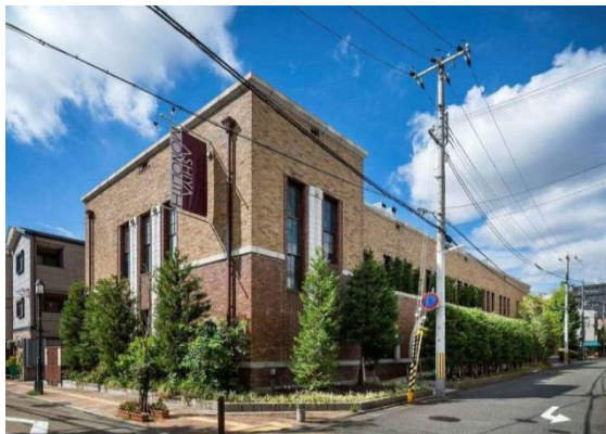
旧芦屋郵便局電話事務室（外観）
