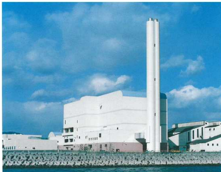
4 代目焼却場（平成 8 年完成：現在稼働中）
