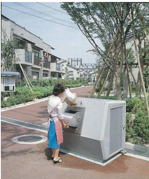
地区投入施設（地上投入口）
