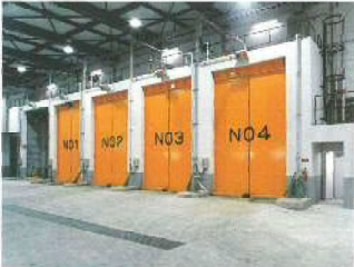
プラットフォームとごみ投入庫 ごみピットへごみを投入します。
