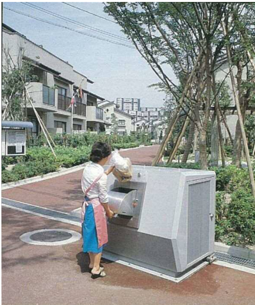
地区投入施設（地上投入口）
