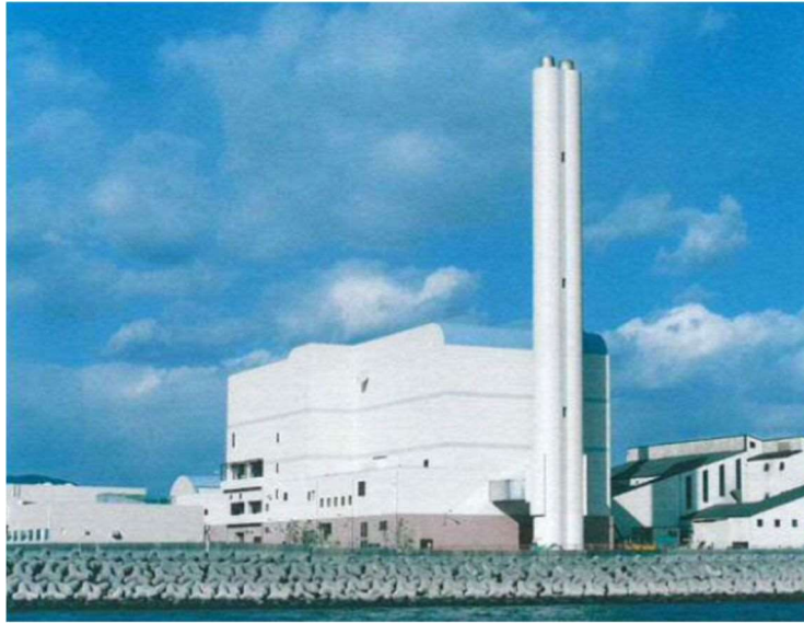
図 2-11 ごみ焼却施設（4代目，現在稼働中）
