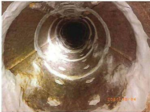
水中ボンド充填 完了
