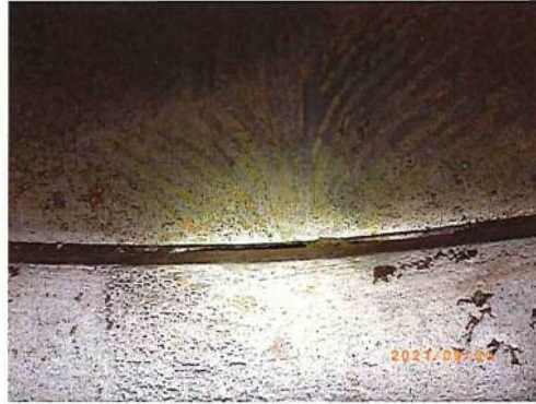
施工後の侵入水確認 (前回補修の目地の喪失確認)
