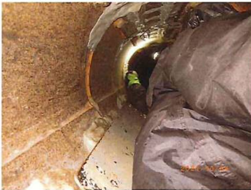
水中ボンド充填 作業中
