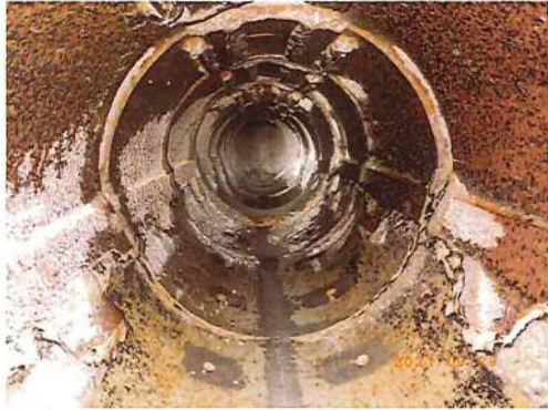
穴あき箇所① 補修前
