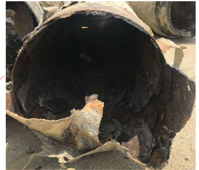
撤去配管の様子
