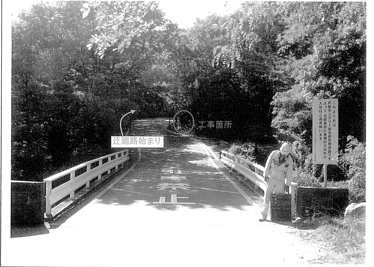
撮影箇所 ① 私道の始まり
