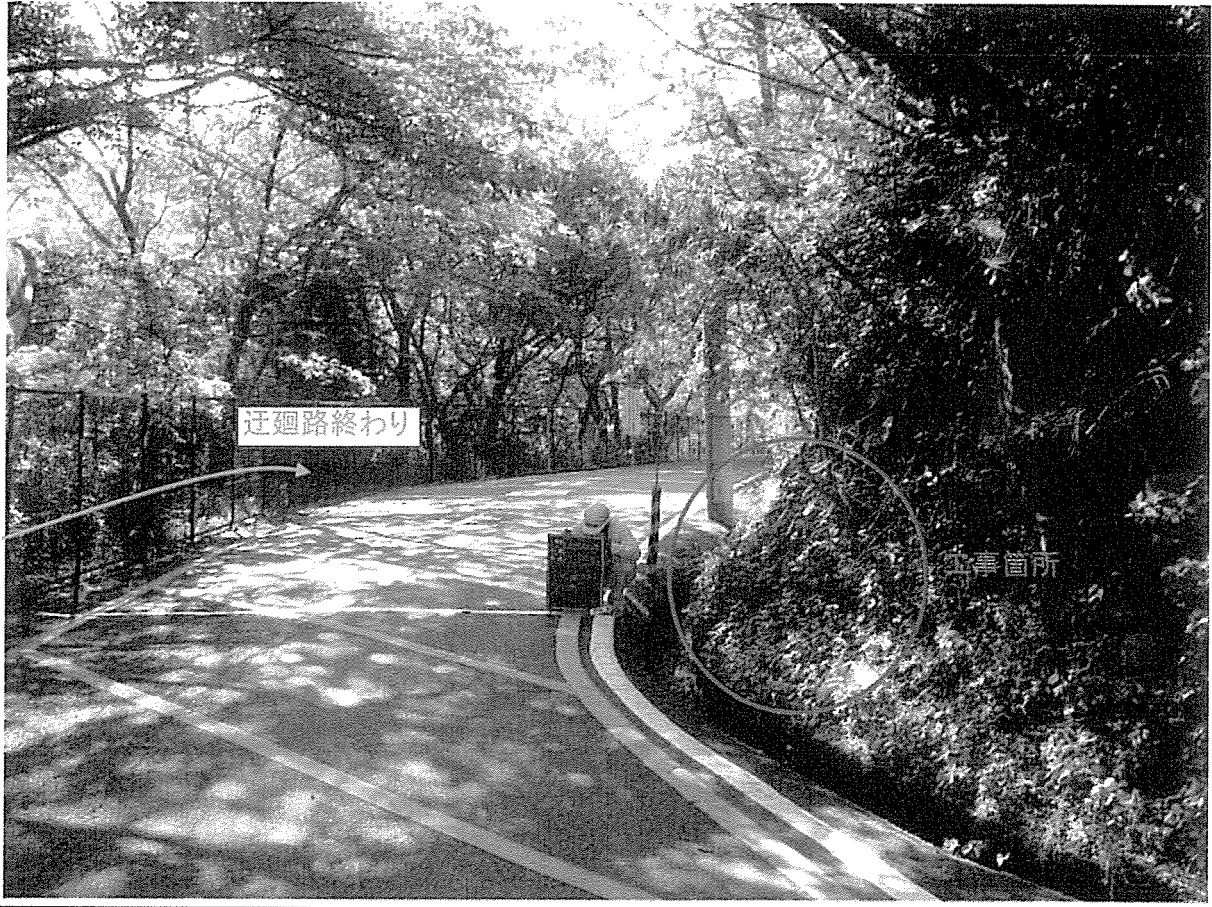
撮影箇所 ③ 拡幅工事箇所
