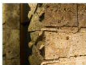
建物のデザインを特徴づける大谷石の瓦貼。近畿地方の瀧沢石の産地帯では、日撃石(ひつげき)や石川(いしかわ)産の山吹石(やまぶきいし)が使われていることが多い。
