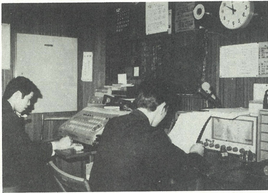
119番の通報を受けて指令を出す通信室
