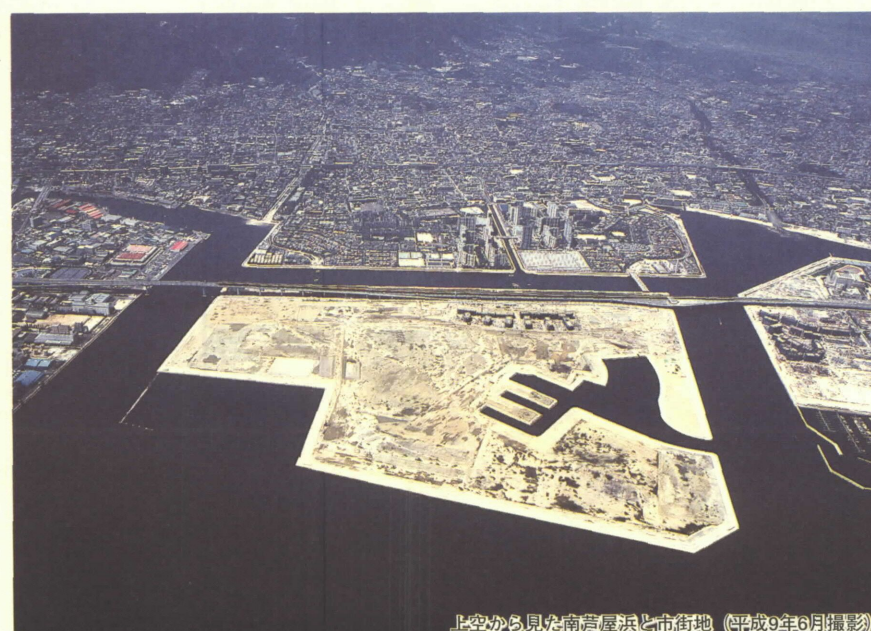
上空から見た南芦屋浜と市街地(平成9年6月撮影)
