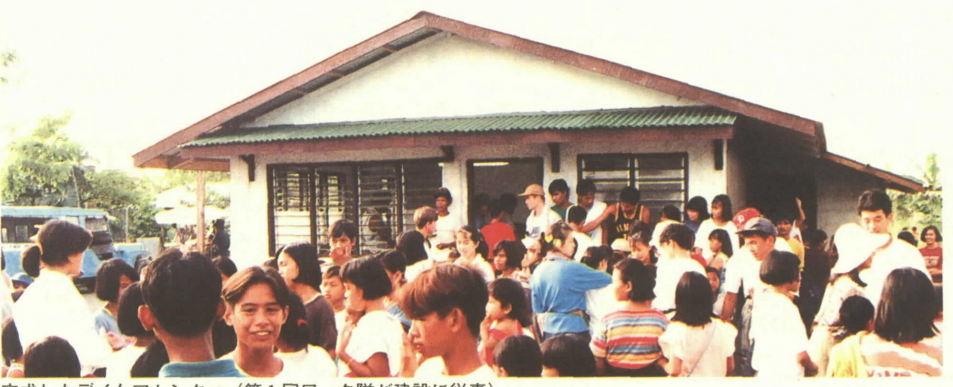
完成したデイケアセンター(第1回ワーク隊が建設に従事)
