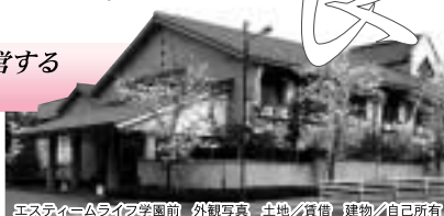
エスティームライフ学園前 外観写真 土地/賃借 建物/自己所有
