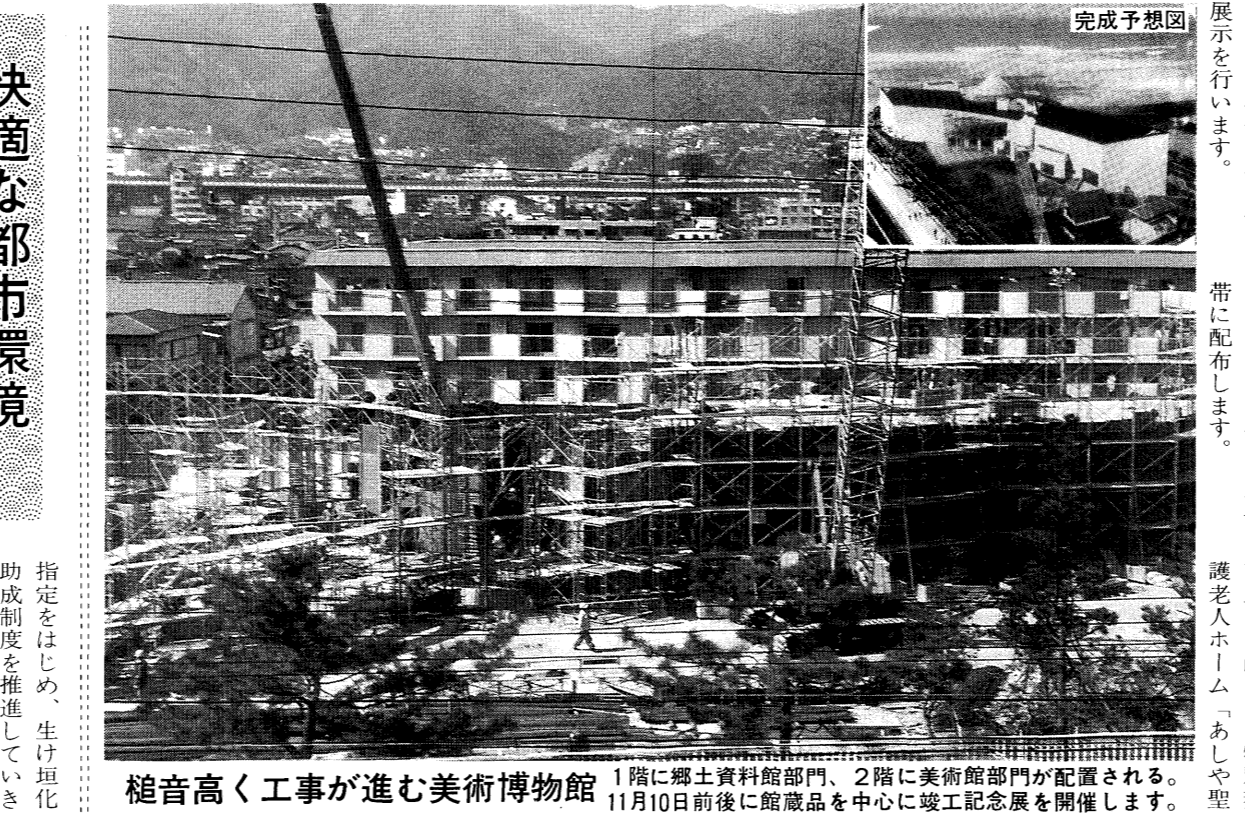
音高く工事が進む美術博物館
