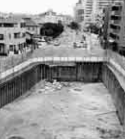
山手幹線芦屋川トンネル東方で出土した業平・松ノ内遺跡(縄文～中世)
