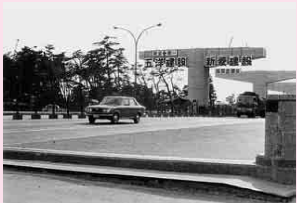
阪神高速道路建設工事が進む国道43号・芦屋川橋(昭和43年ころ)
