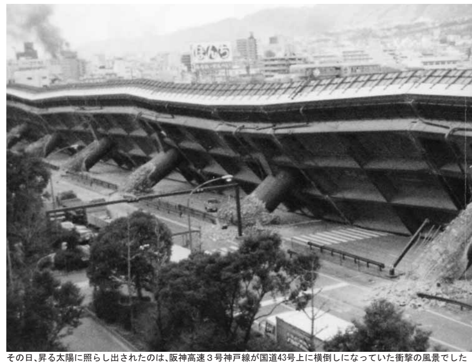
その日、昇る太陽に照らし出されたのは、阪神高速3号神戸線が国道43号上に横倒しになっていた街撃の風景でした
