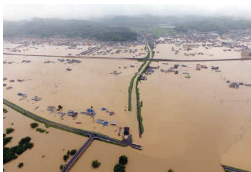
記録的豪雨により住宅地へ越水した小田川(倉敷市)
