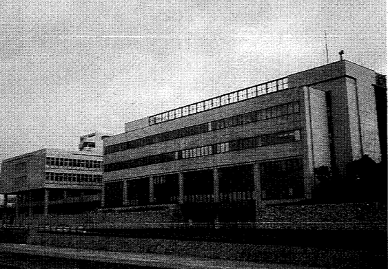
市庁舎北館と南館
