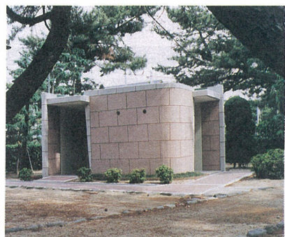
改築された芦屋公園南の公衆トイレ
