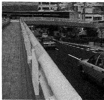
庁舎前広場に通じる歩道橋
