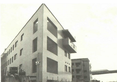
修復工事が進む「あしや喜楽苑」
