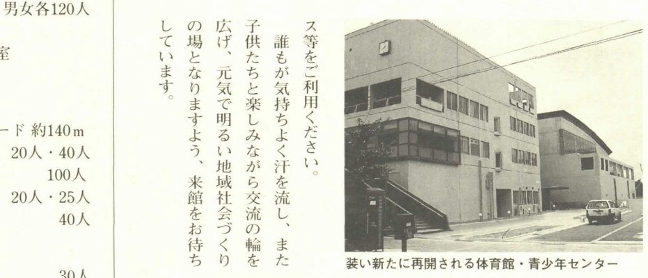
装い新たに再開される体育館・青少年センター
