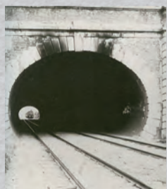
官設鉄道芦屋川隧道 (当時)
