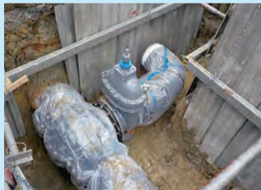
GX管(100年耐用の耐震管)布設工事(岩園町)
