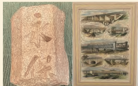
阪神大水害により折れた永保橋親柱 イラストイッドロン・ド・ニユース明治9(1876)年
