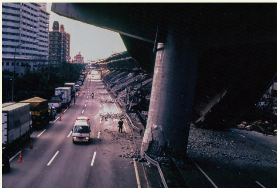
根元から倒壊した阪神高速神戸線
