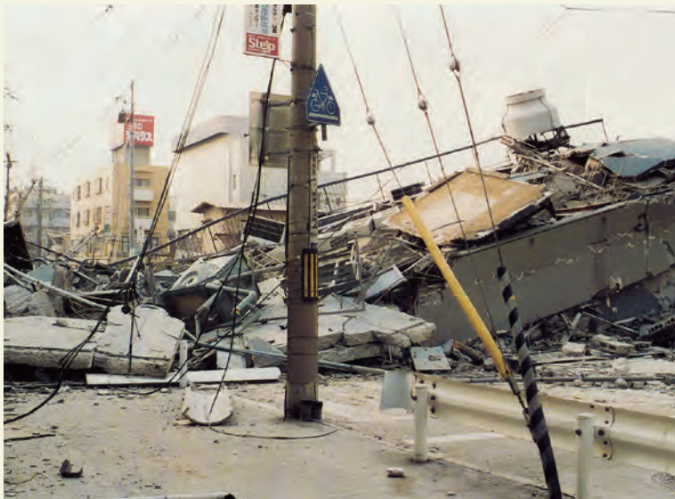
上宮川町 倒壊した芦屋アートセンター
