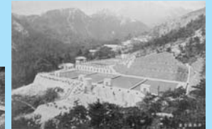
建設当時の奥山浄水場
