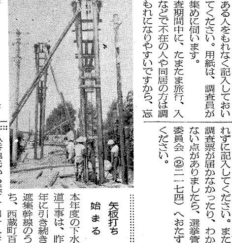
矢板打ち 始める 本年度の下水道工事は、昨年引き続き、西蔵町百八番地から浜町百四十二番地先までの約七百坪に、内径千八百・千五百・千二百の下水道を埋設します。
