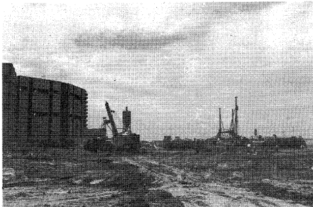
高層住宅のそばで基礎工事がさかん
