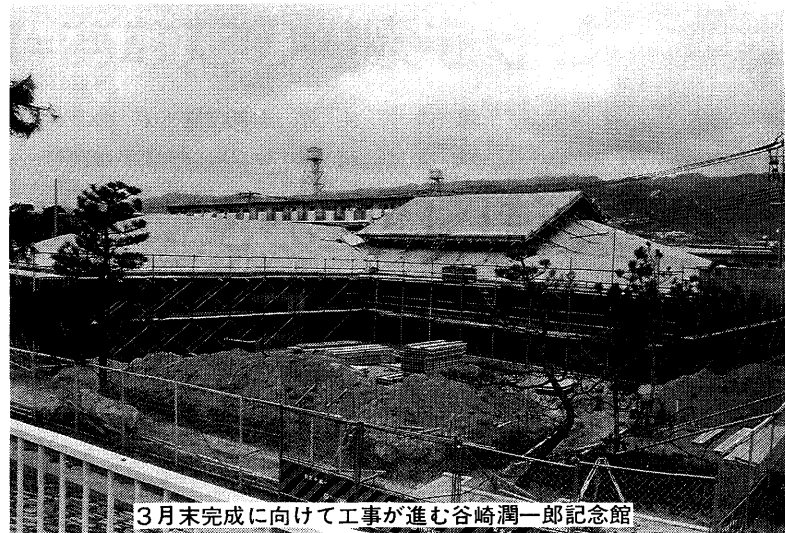
3月末完成に向けて工事が進む谷崎潤一郎記念館
