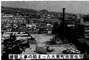
建替工事の始まった大東町市営住宅
