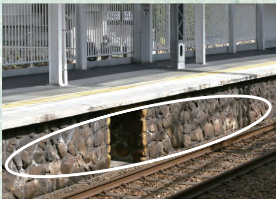
阪神打出駅上りホーム （提供：阪神電気鉄道株式会社）
