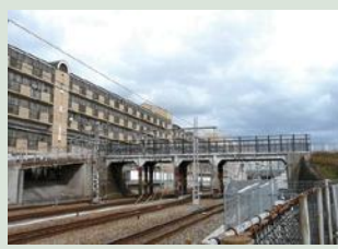
撤去が予定されている第一跨線橋
