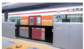
鉄道各社が整備目標を発表したホームドア(写真は阪神大阪梅田駅)
