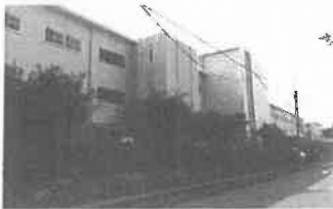
【3階建ての精道中学校北側校舎】
