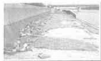
高潮被害の状況
