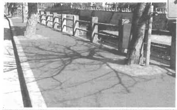
早急に対策工事
