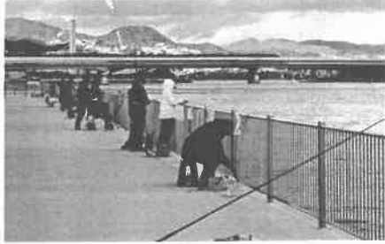
試験的に開放されている南芦屋浜護岸。多くの釣り客でにぎわうが...
